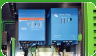
4 Cargador &amp; inversor cargador
